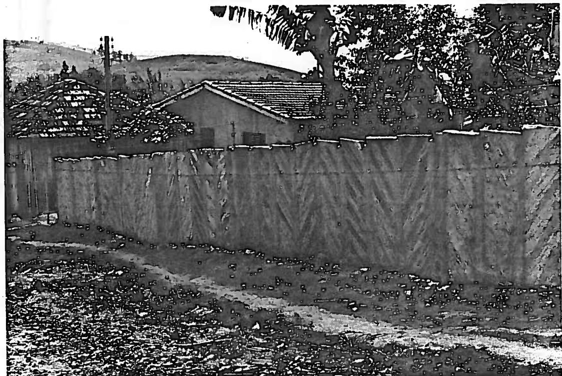
Utilização de "Placas" de Arenito Botucatu silicificado na construção de muros.
