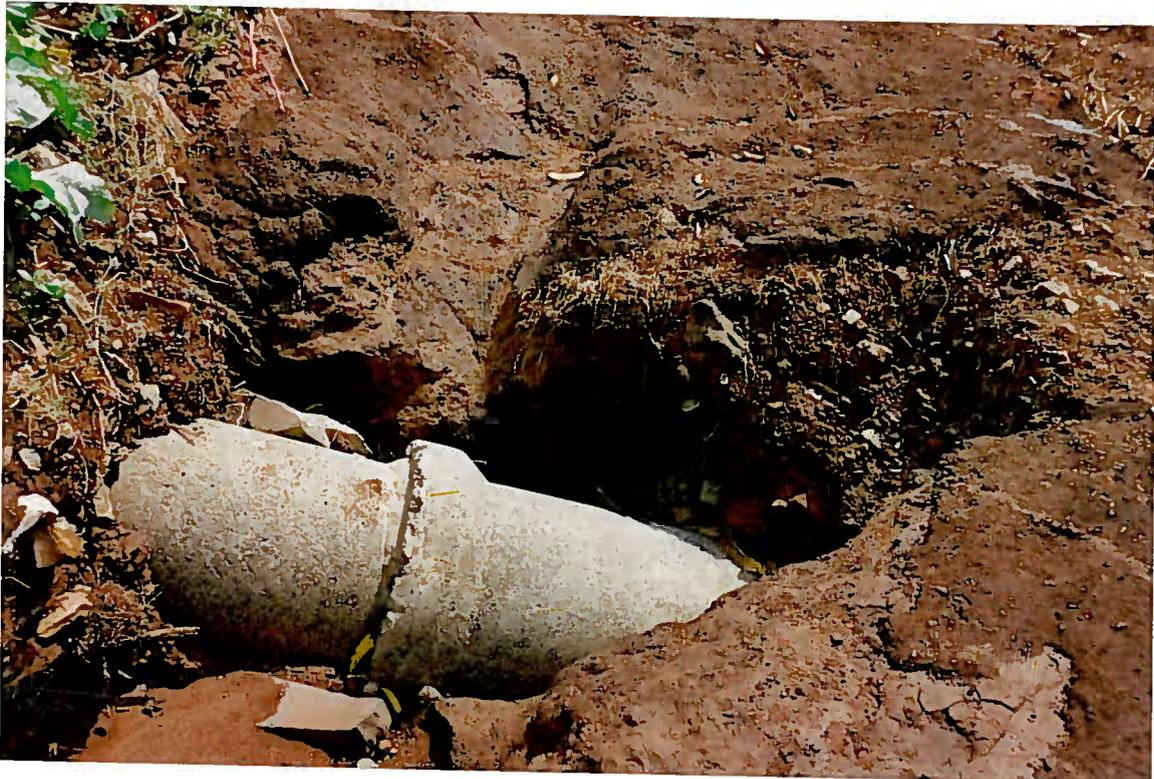
FOTO 9 - Problemas de instalação de infra-estrutura enterrada em zonas de solo litólico na Rua Humberto Contatto.
