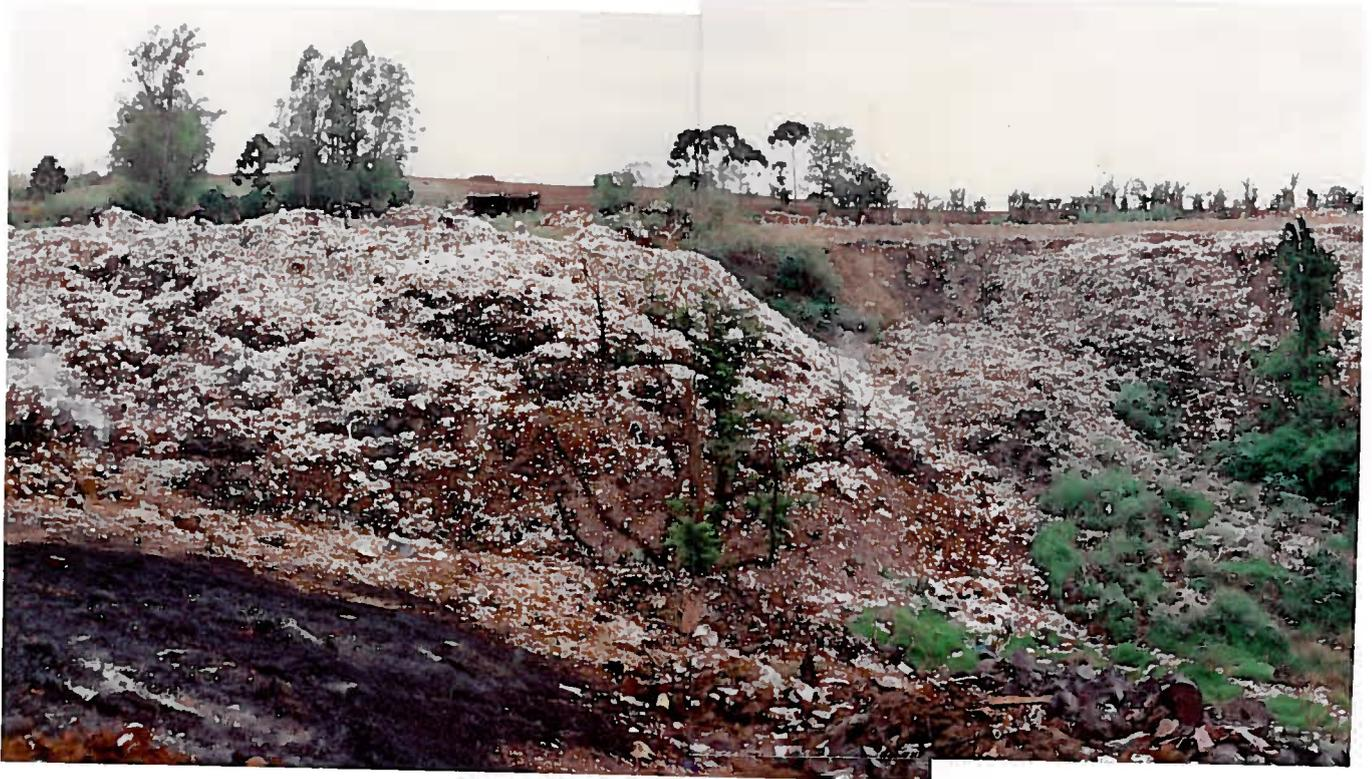
FOTO 7 - Lixão de Apucarana. Notar os taludes instabilizados e as nascentes, no canto inferior direito da foto.
