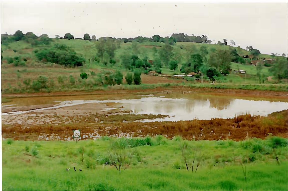
FOTO 4 - Lago assoreado próximo ao Contorno Norte. Em períodos chuvas mais fortes o lago extravasa e danifica seriamente a estrada sobre a barragem, a jusante.
