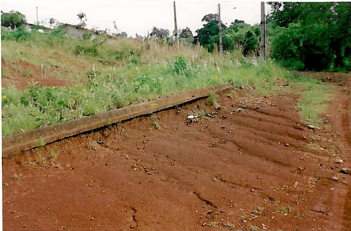
**FOTO 1 - Erosão em solos intermediários e profundos em rua exposta à erosão laminar, originando meios-fios suspensos.**
