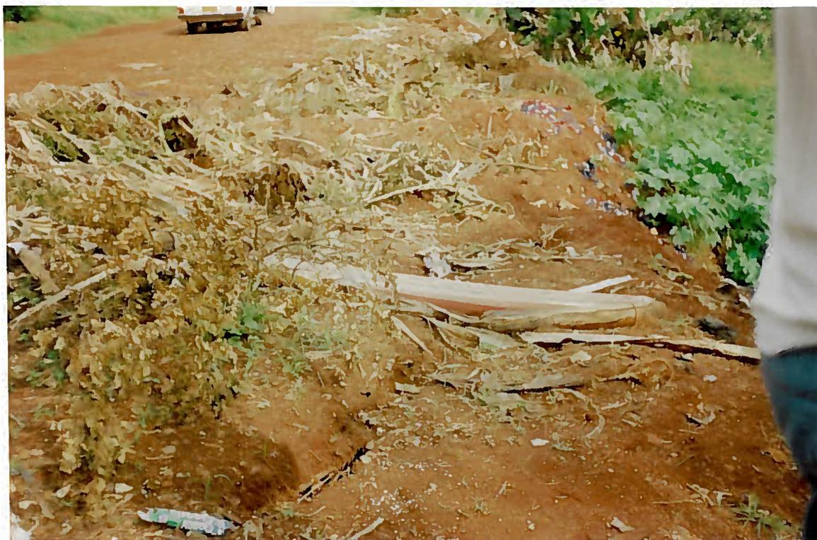
FOTO 6 - Fendas no terreno provocadas por instabilização do material do talude, ao final da Rua Augusto Weiand.
