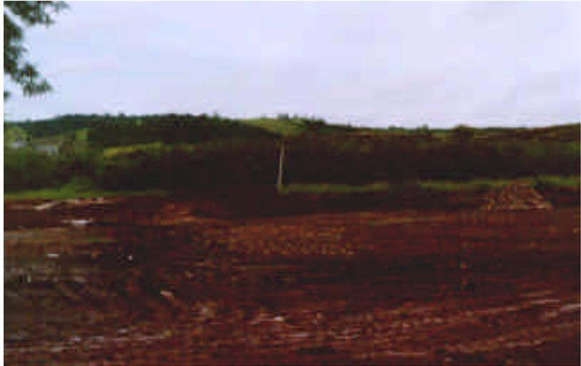
Foto 7. Aterro sanitário em Ibiporã, com o lixo sendo recoberto por camadas de solo.
