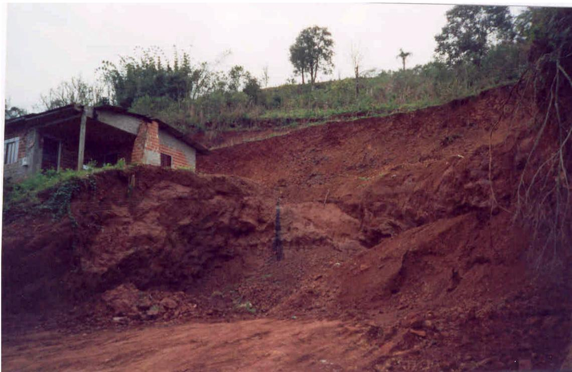
**Foto 27** – Aspecto dos cortes e aterros executados em loteamento implantado em área de risco geológico
