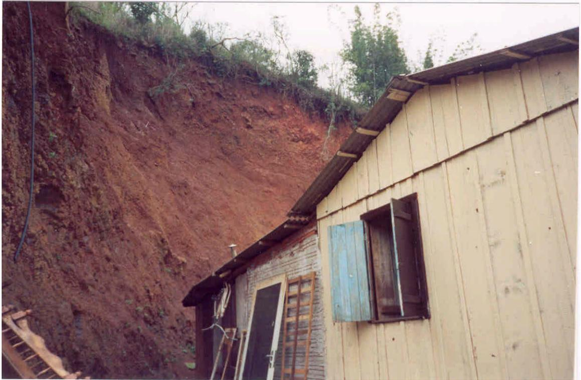
**Foto 29** – Situação de risco geológico emergencial que necessita medidas urgentes de correção, sob pena de perdas materiais e de vidas humanas (ponto FB-36)
