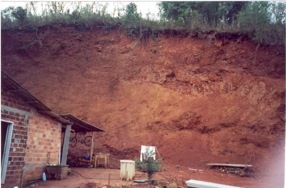
**Foto 30** – Aspecto do risco a que estão expostos os moradores de loteamento implantado sem critérios técnicos adequados em áreas com muito alta declividade e solos impróprios para corte em taludes côncavos ou verticais
