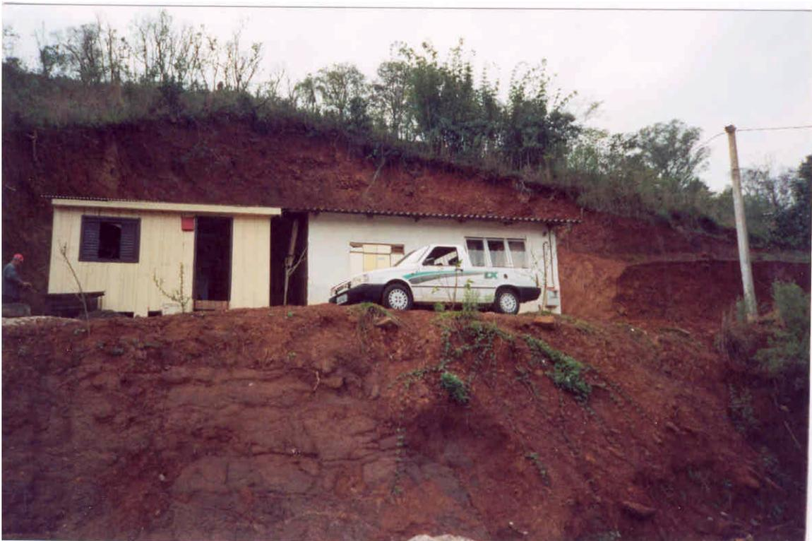
**Foto 26** – Execução de cortes e aterros sem critérios técnicos adequados em áreas com muito alta declividade (ponto FB-36)
