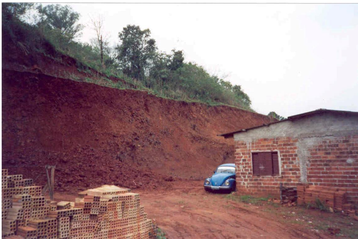
**Foto 28** – Solos desagregados englobando blocos e fragmentos de rocha, com risco emergencial de quedas e escorregamentos (ponto FB-36)
