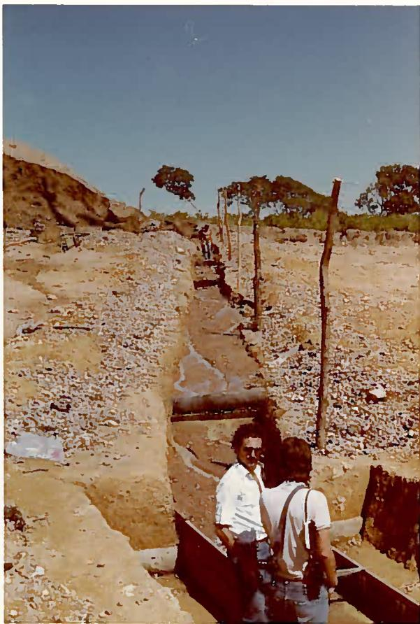
Foto 6 b: Com a água desligada, ao término de uma corrida, vê-se, no canal de alimentação, as quedas de deslameamento (degraus). Elas são protegidas por madeira para evitar que sejam erodidas pelo fluxo d'água. Estas quedas agem como ríflés, concentrando os grânulos maiores de minério, juntamente ao fino, nas suas bases. Este material deve ser coletado e levado ao bateamento.
