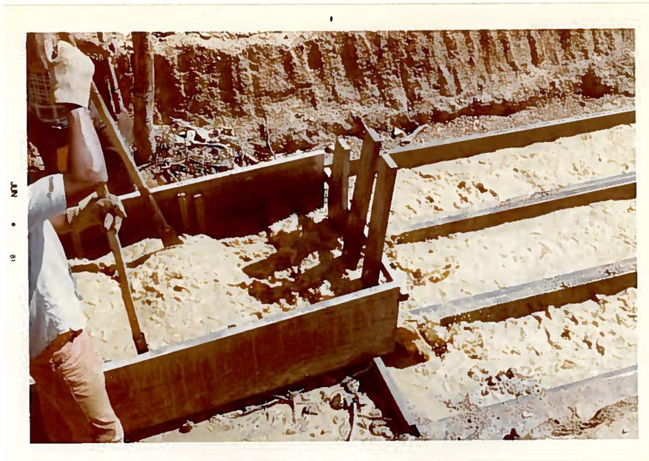
Foto 9 a: Passagem da bica superior para as três bicas inferiores. Notar os obstáculos postos na saída que permitem uma re-partição da polpa para as três bicas inferiores.
