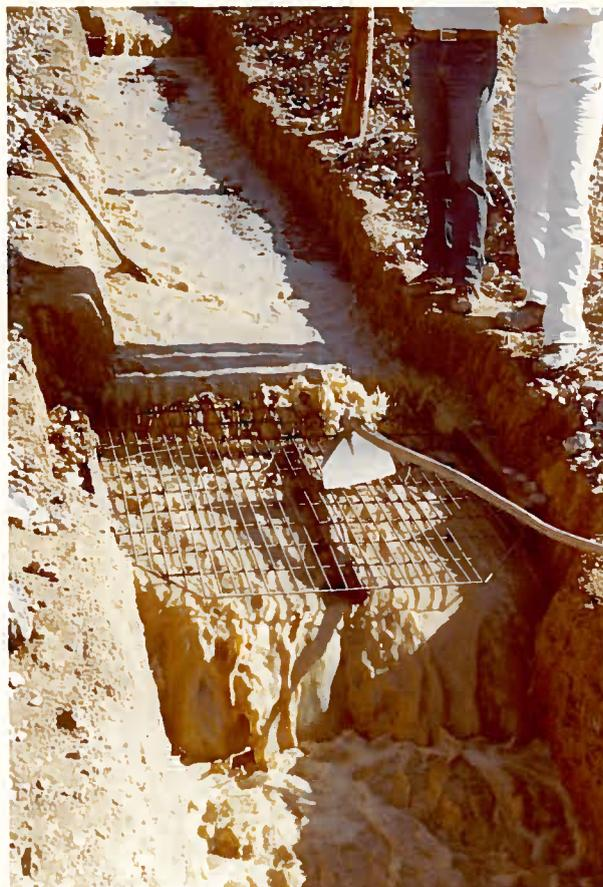
Foto 7 - Grade-peneira, instalada no canal de alimentação das bicas, com a finalidade de reter o cascalho grosseiro e blocos trazidos pela polpa. A malha da grade é retangular, de 15 x 4 cm.
