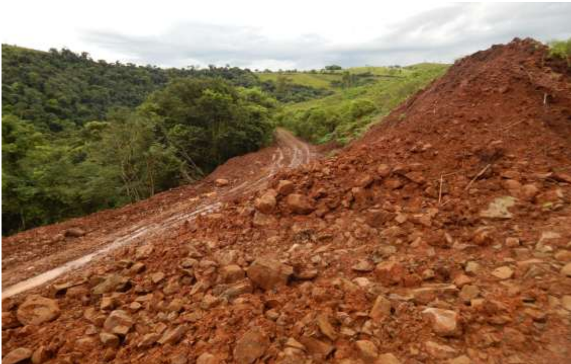
Foto 3: esta é a parte inferior ao deslizamento, onde foi depositado todo o material mobilizado sobre a estrada que no dia da vistoria já havia sido desobstruída.
