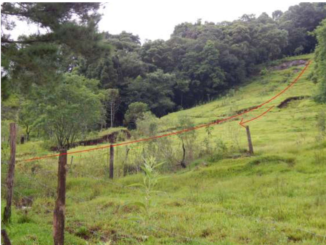
Foto 10: deslizamento rotacional de pequeno porte sem danos.
