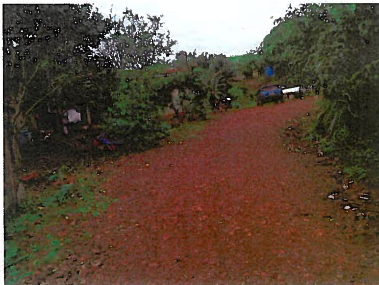
Foto 4. Trinca subparalela à principal, 80 m abaixo da casa, em cuja extensão à esquerda da foto (sentido W), apareceu surgência de água após a ruptura do solo.
