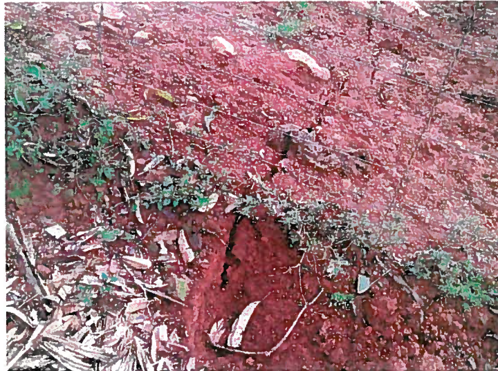
Foto 1. Trinca principal, 20 m a E da moradia.
